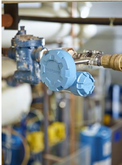
Figura 4. Monitor acústico pode identificar modos de falha comum em purgadores e reportá-los para manutenção.
