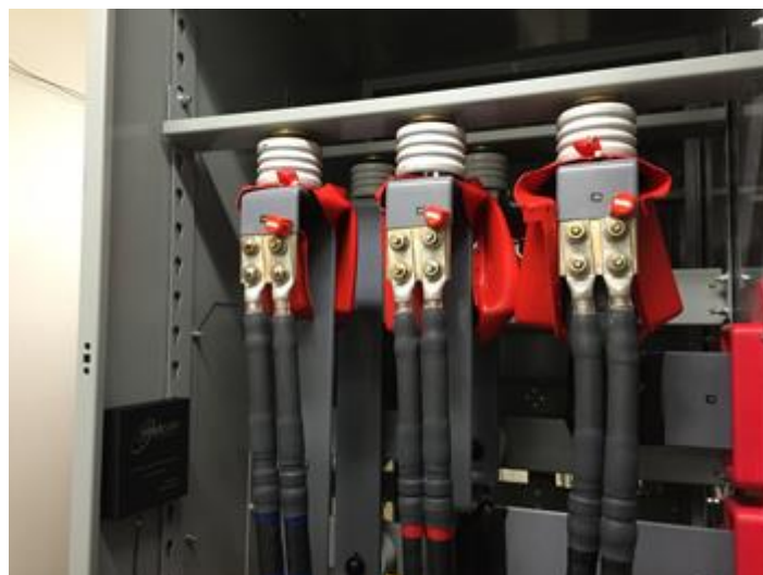
Figura 5. Sensores podem ser adicionados ao quadro elétrico para monitorar a condição continuamente, reduzindo a necessidade de inspeções.
