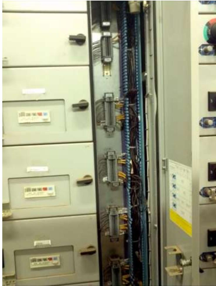
**Derivação através de Bornes nos cabos Profibus**
