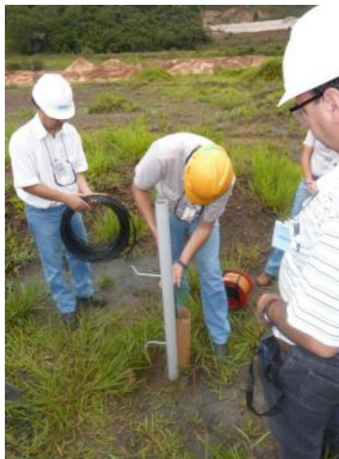
Instalação da sonda
