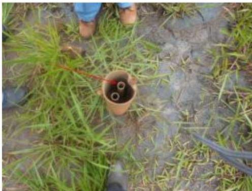
Furo para medição do nível
