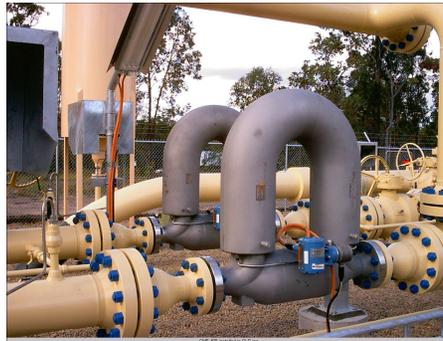
**Solução:** Coriolis Micro Motion Elite (CMF)
