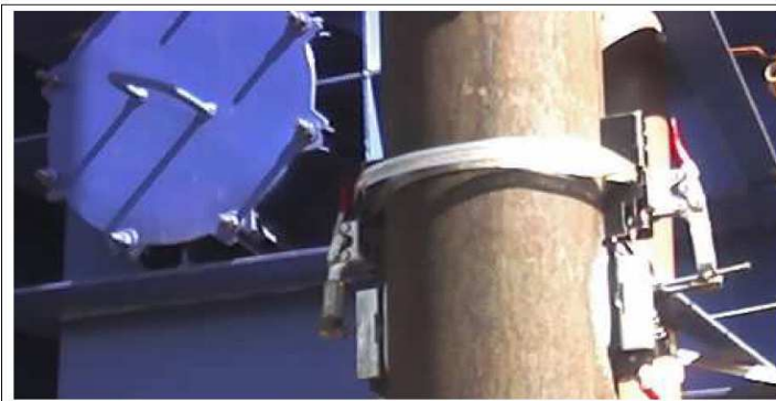
Imagem da instalação – Clamp-On – não intrusiva – Tubulação de Recalque de Esgoto Bruto
