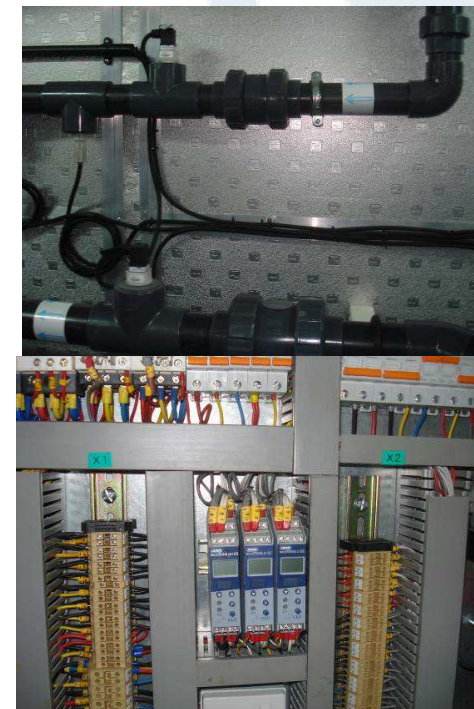
Osmosis inversa (RO) unidade com transmissor JUMO ecoTRANS LF 03 e sensor de condutividade JUMO tecLine 202924
