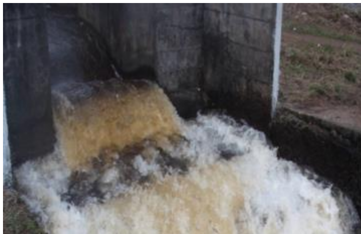
Dissipadora EEAB Capivari
