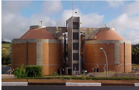
Biodigestores
